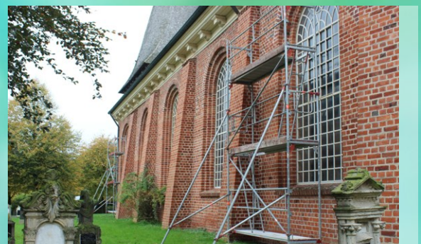
Probeentnahme für die Putzsanierung der Kirche
